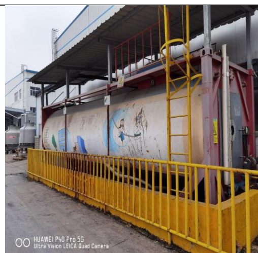
罐装物料存放区（围堰）
