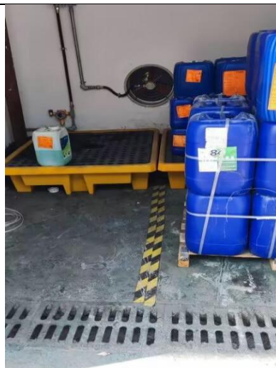
危废库导流沟
