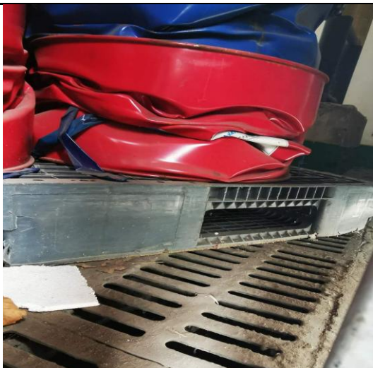
危废库导流沟
