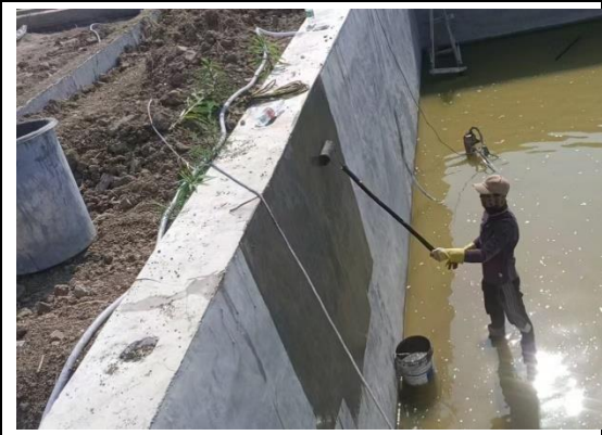
事故池防渗施工
