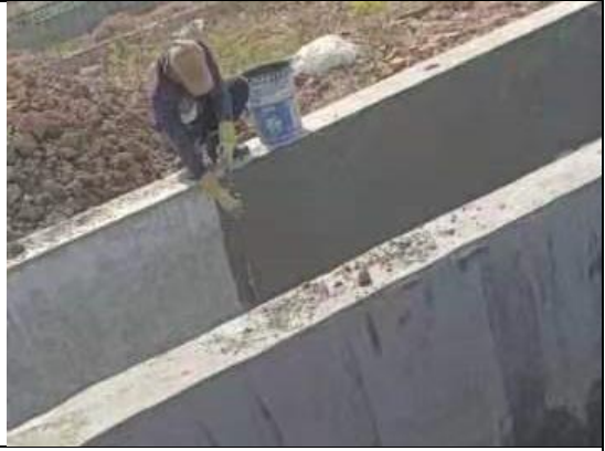
初期雨水池防渗施工
