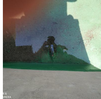
罐区应急池控制阀
