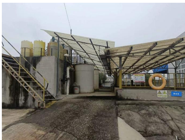
图 3-8 厂区综合污水处理站
