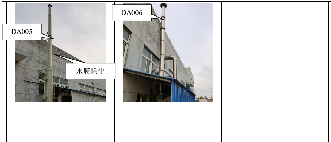
图 3-7 废气处理设施
