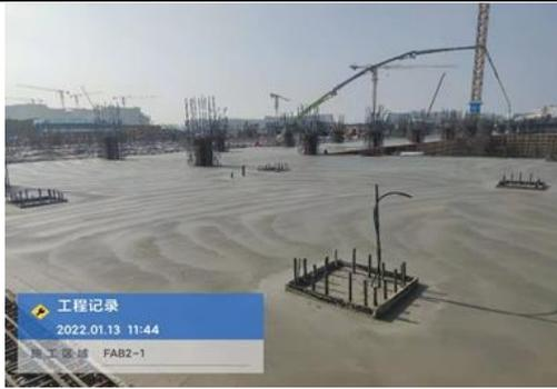
芯片生产厂房 201A 筏板基础施工
