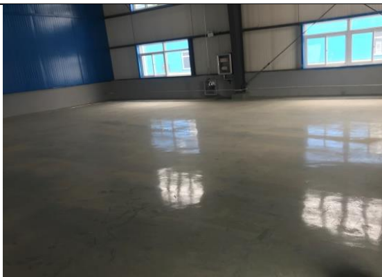
危废暂存间内环氧地坪
