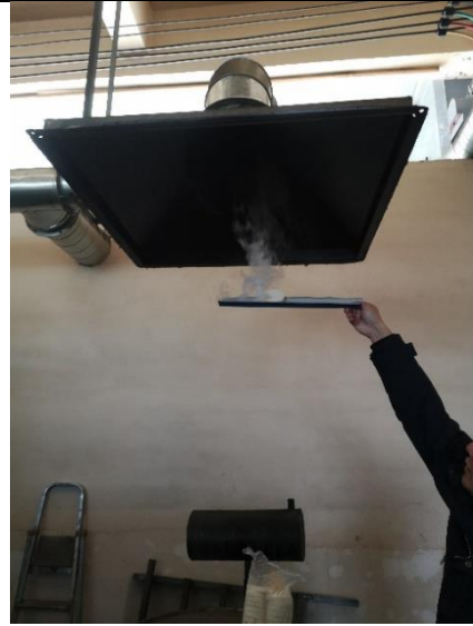
图 3-2-2 粉碎废气 G2 集气罩及集气管图
