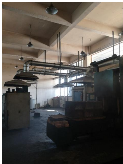
图 3-2-5 固化废气 G5 集气罩及集气管图
