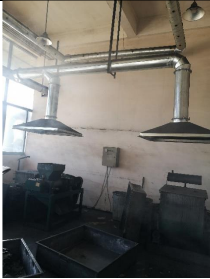
图 3-2-1 捏合废气 G1 集气罩及集气管图
