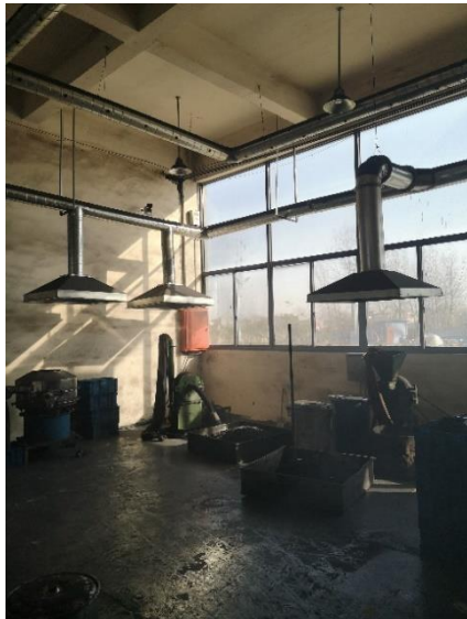
图 3-2-3 筛分废气 G3 集气罩及集气管图
