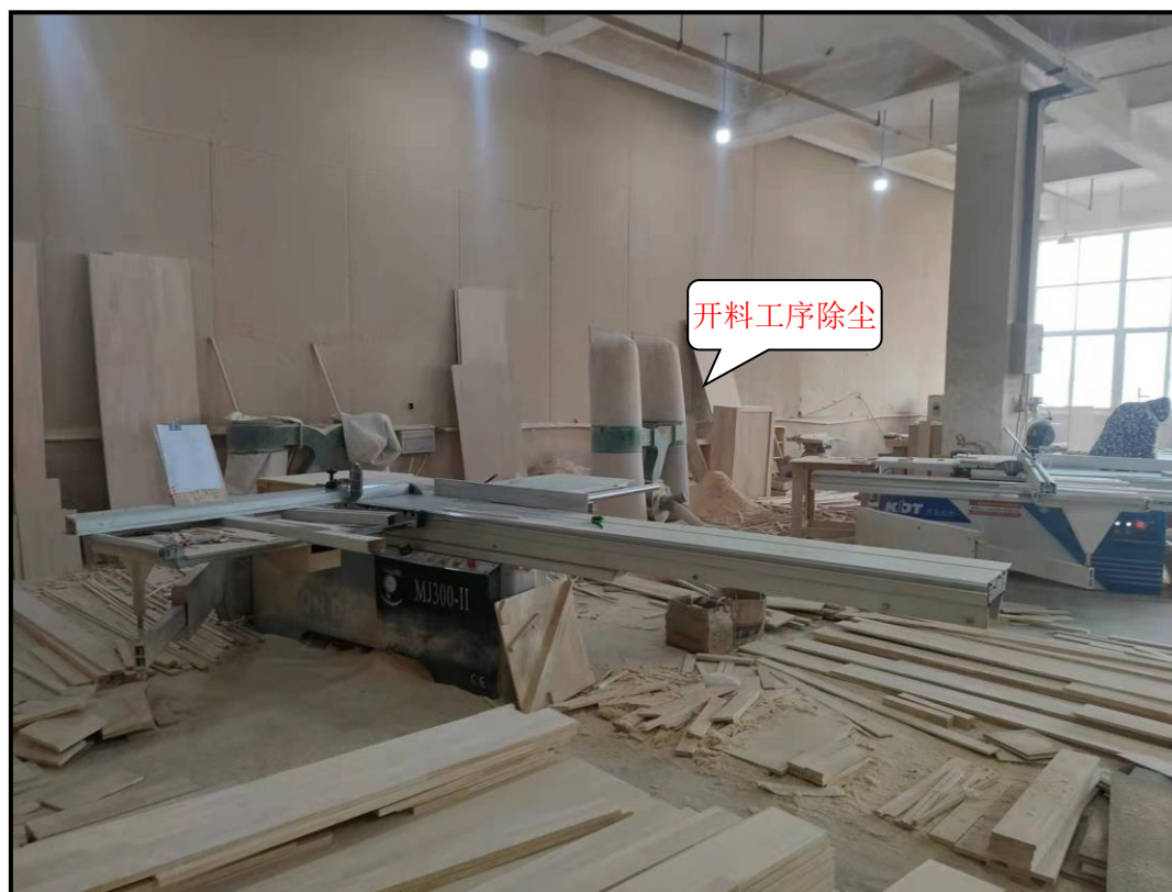
图 3-2 开料车间除尘设施
