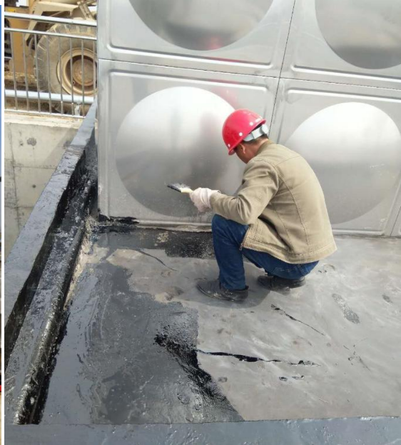
废机油箱及堰区围堰聚氨酯涂料涂层
