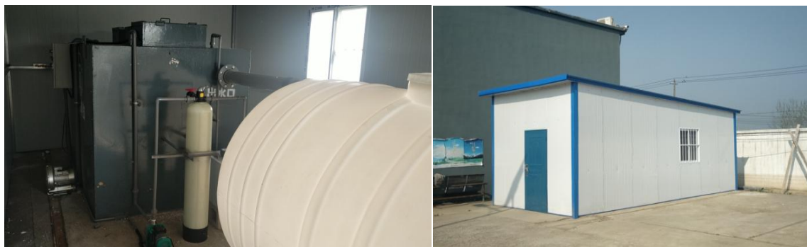
微动力处置设施+收集吨桶污水处理站
