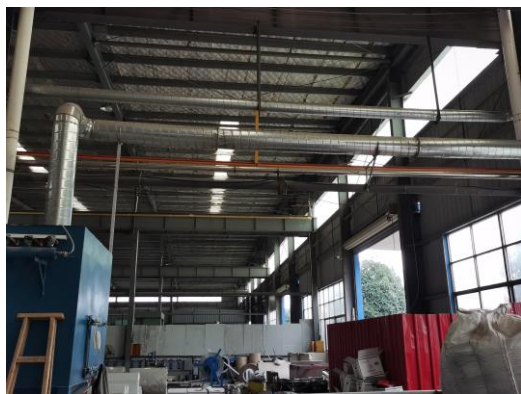
图 3-4-4 手动喷塑尾气送至 DA003
