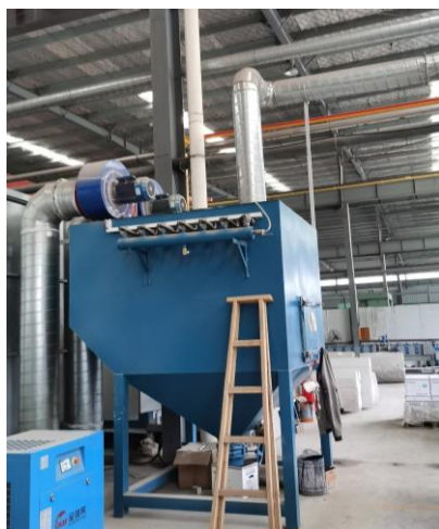
图 3-4-3 手动喷塑废气处理设施 TW003 除尘器 (DA003)
