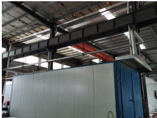
图 3-6-4 固化烘烤房集气罩图
