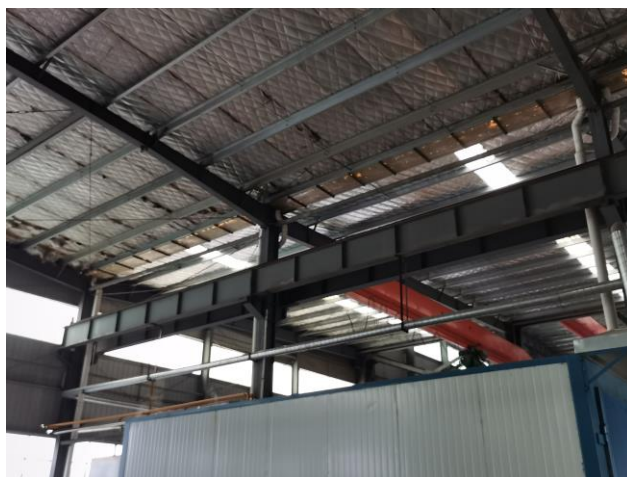
图 3-6-7 烘烤房集气管道送 TW004 (DA004)
