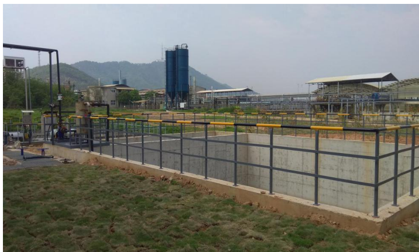
100m 3 雨水收集池和 400m 3 事故应急池
