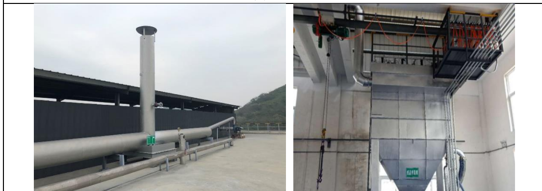
DA306 排气筒及废气处理设施
