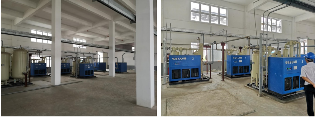
空压机组、制氮机组厂房隔声
