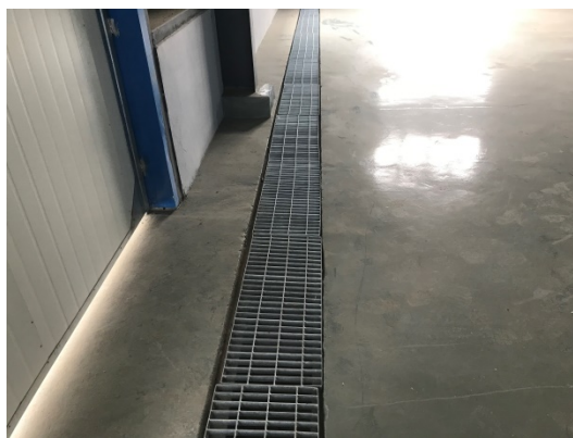
暂存间内四周设置截流沟
