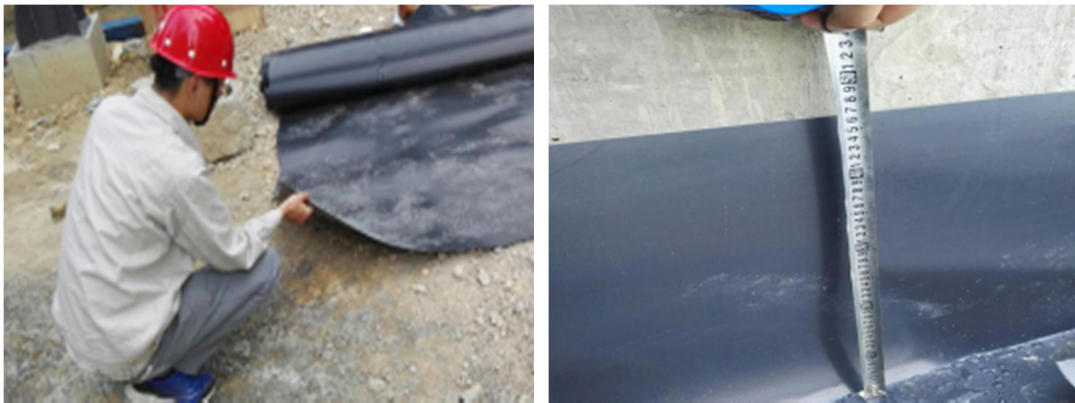
环境监理员检查危废暂存间 HDPE 膜
