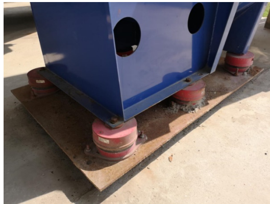
风机基础采用减振
