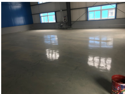
危废暂存间内环氧地坪
