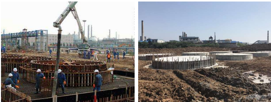
成品及原料罐区抗渗混凝土浇筑
