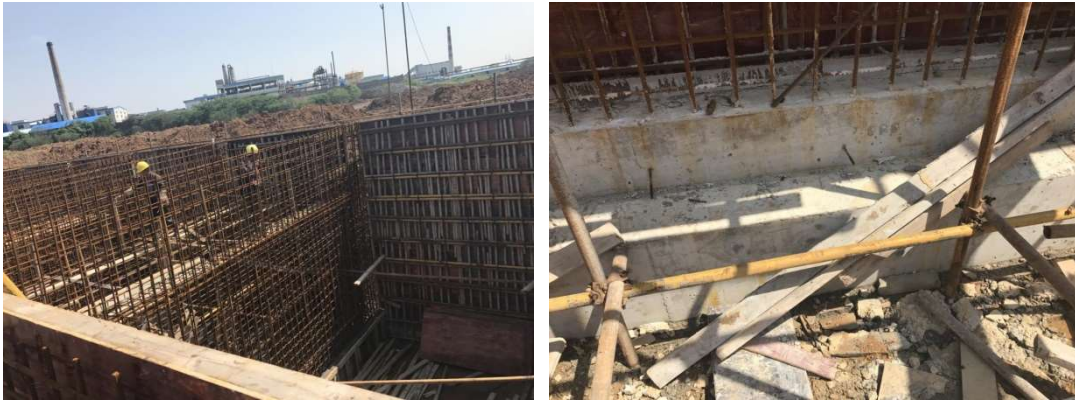
污水处理站水池浇筑完成
