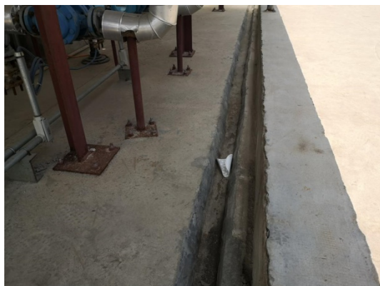
生产装置区设置围堰及截流沟
