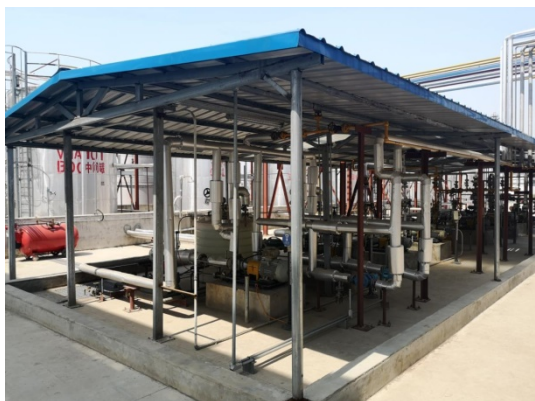
生产装置区设置围堰及截流沟
