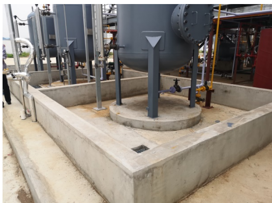
生产装置区设置围堰
