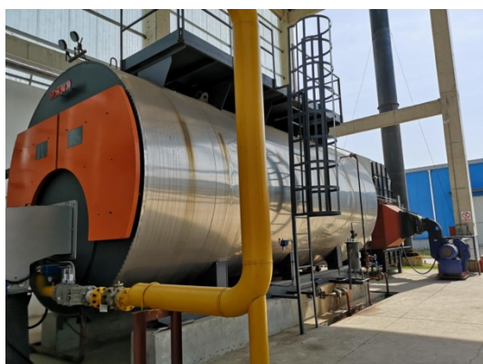
天然气蒸汽锅炉及15m高排气筒
