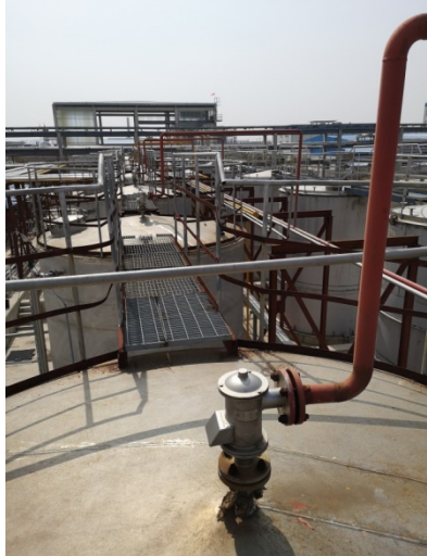
中间罐废气收集管
