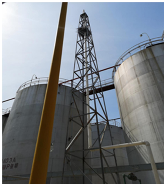
罐区排气筒 (15m)
