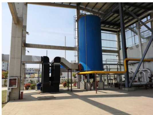
导热油炉及15m高排气筒
