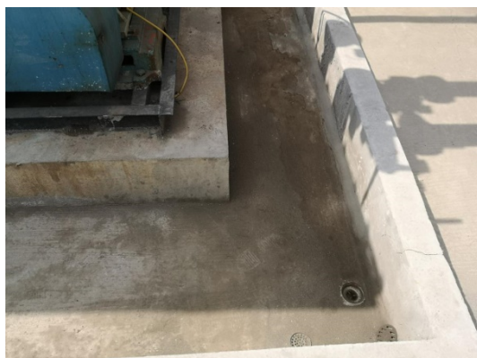
生产装置区设置围堰
