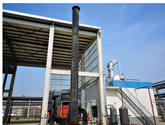
天然气蒸汽锅炉及15m高排气筒
