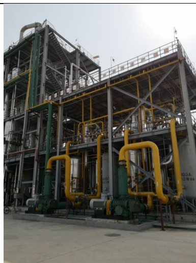
真空尾气收集管
