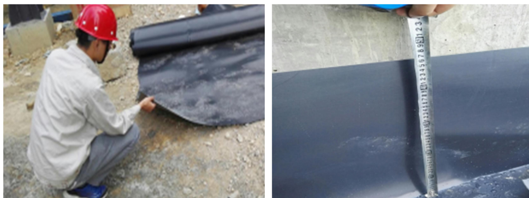
环境监理员检查危废暂存间 HDPE 膜
