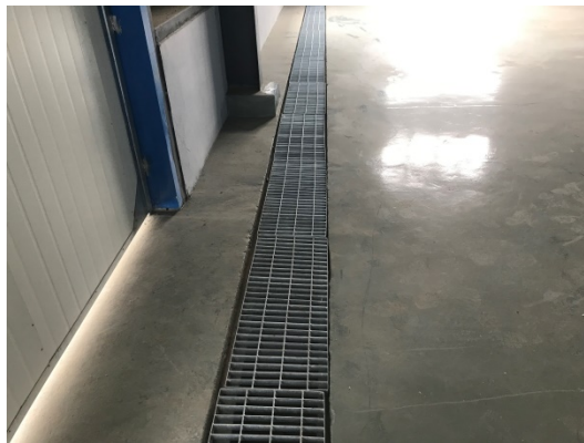
暂存间内四周设置截流沟
