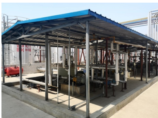
生产装置区设置围堰及截流沟
