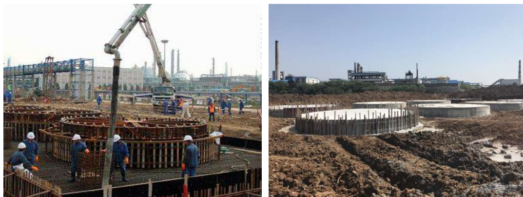
成品及原料罐区抗渗混凝土浇筑
