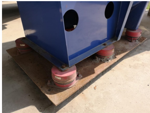
风机基础采用减振
