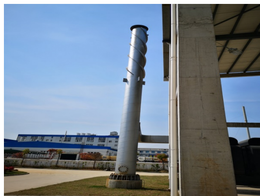
导热油炉及15m高排气筒
