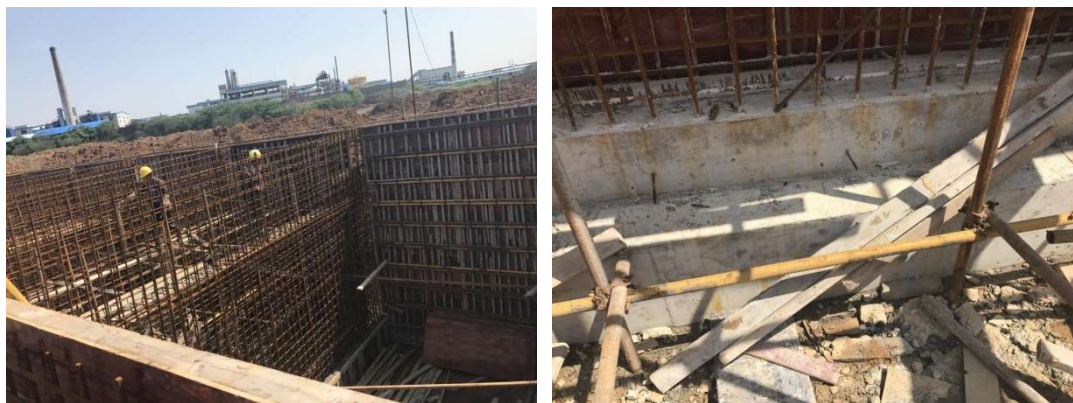
污水处理站水池浇筑完成
