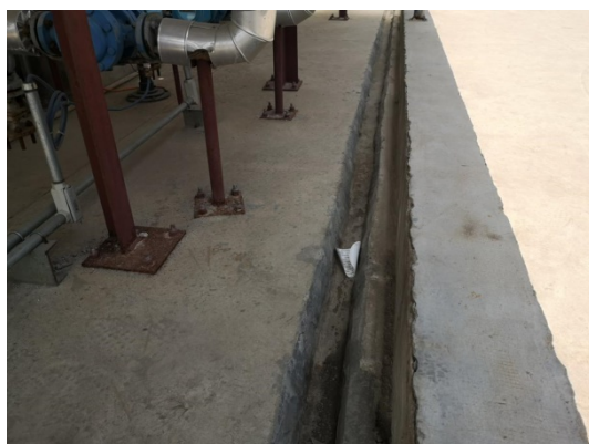
生产装置区设置围堰及截流沟
