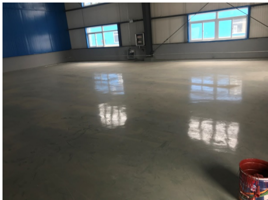
危废暂存间内环氧地坪
